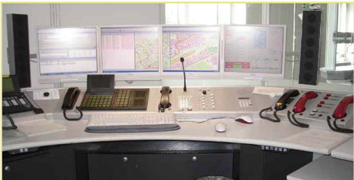
Notruf- und Serviceleitstelle (NSL)
